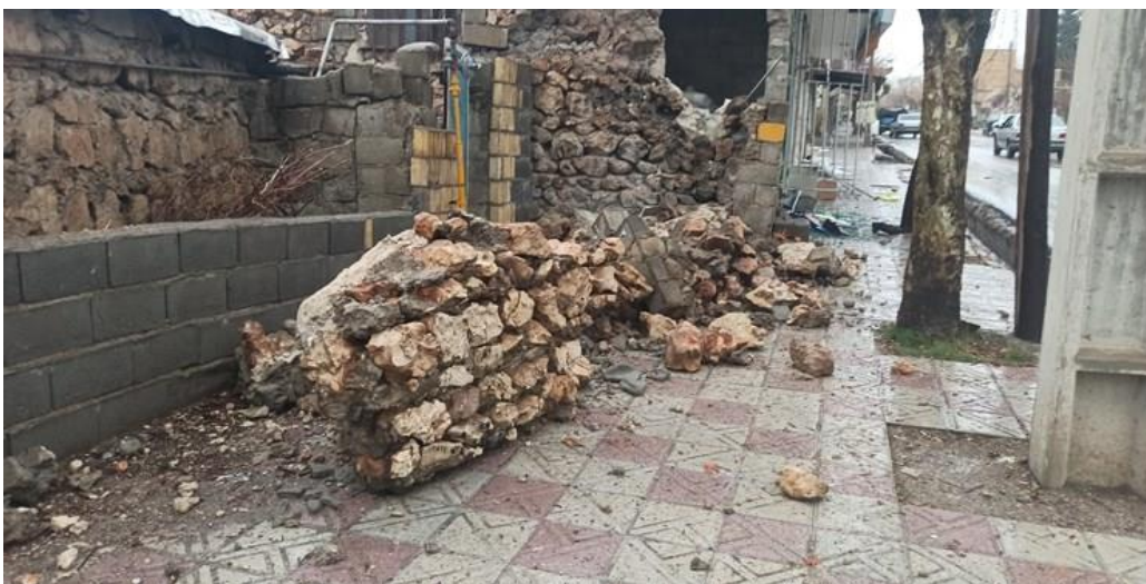
شکل (۱۲) - ادامه: ریزش دیوارهای پیرامونی به علت عدم تامین کشش در ملاتھا و عدم اجرای وال پست
