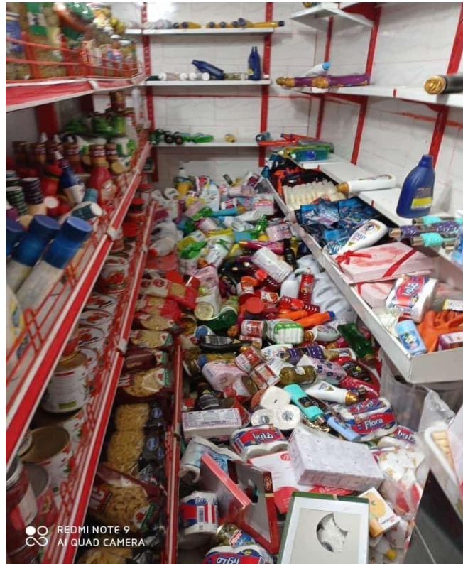
شکل (۱۳): عدم مهار مناسب اجزای غیرسازه‌ای
