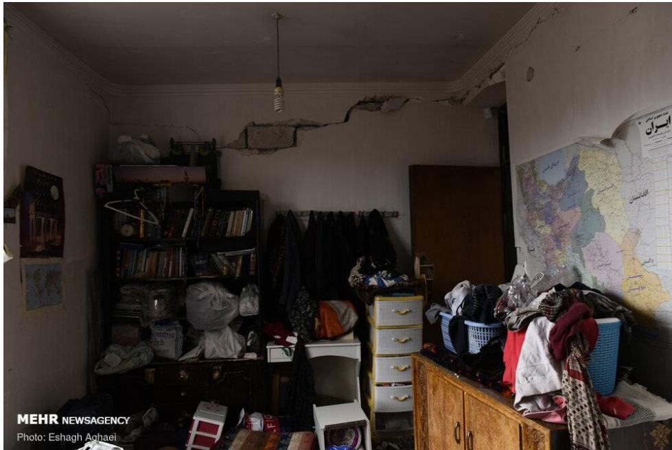
شکل (۶) - ادامه: ایجاد ترکهای مورب و قطری و ترک افقی زیر سقف
